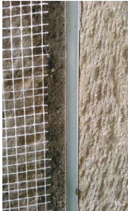
16. Λεπτομέρειες από την κατασκευή του νέου τμήματος αρτιφισιέλ παράλληλα με την υδρορρόη που αντικαταστάθηκε. Details showing the construction of a new section of artificielle plaster parallel to the downspout that was replaced.
